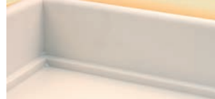
Fräsen der Verbindungen von Mineralwerkstoffen
